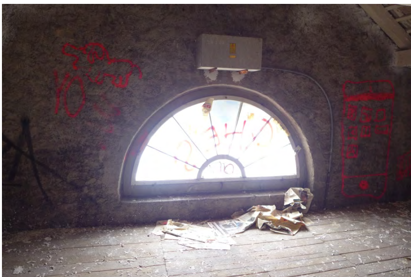
Fabrikgebäude Luxram, 2. DG Halbrundfenster (P1300940)
