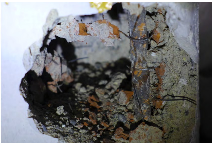
Fabrikgebäude Luxram, Stahlstütze, Rabitznetz, Verputz (P1310261)
