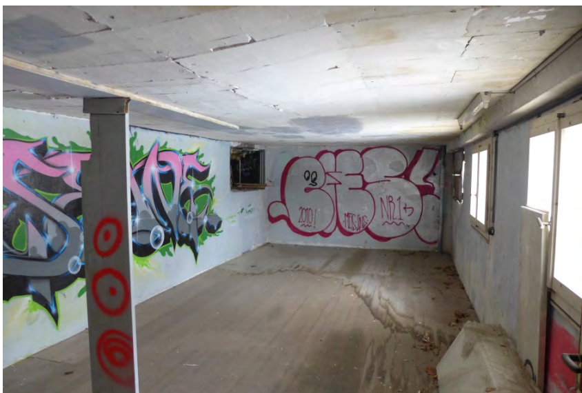
Fabrikgebäude Luxram, Zwischengeschoss Raum bei Treppenhaus (P1300912)
