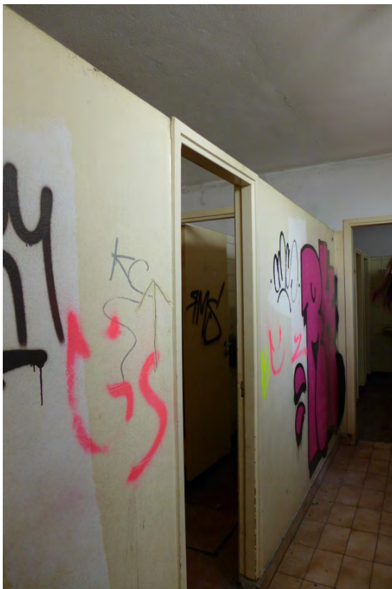
Fabrikgebäude Luxram, EG Toiletten (P1300904)
