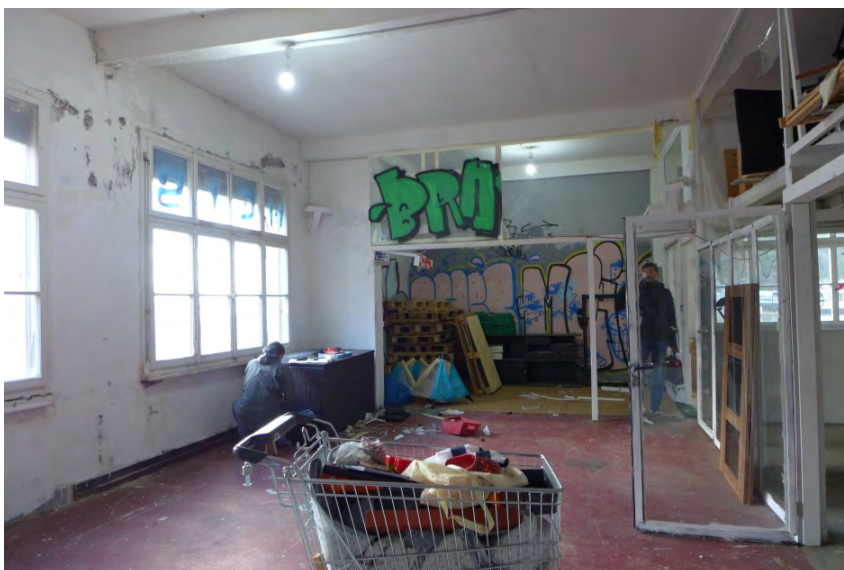
Fabrikgebäude Luxram, 1. DG (P1310212)
