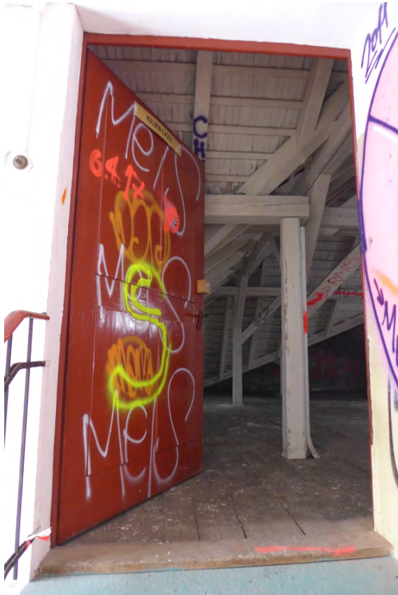
Fabrikgebäude Luxram, 2. DG Zugang (P1300937)
