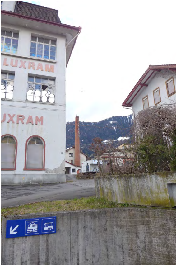
Fabrikgebäude Luxram, dahinter Kesselhaus mit Hochkamin (P1310177)
