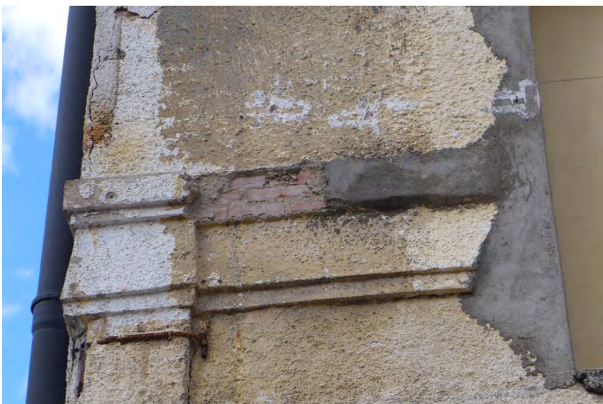
Fabrikgebäude Luxram, Südfassade Backstein bei Gesims (P1310147)
