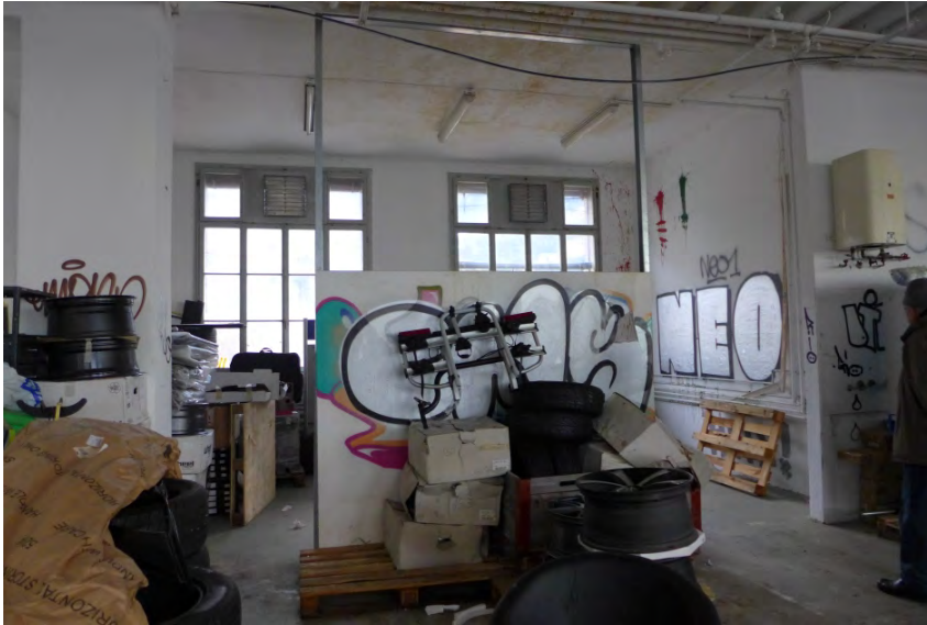
Fabrikgebäude Luxram, 2. OG Bereich neben Treppenhaus (P1310245)
