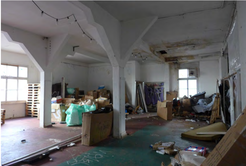
Fabrikgebäude Luxram, 1. DG (P1310203)
