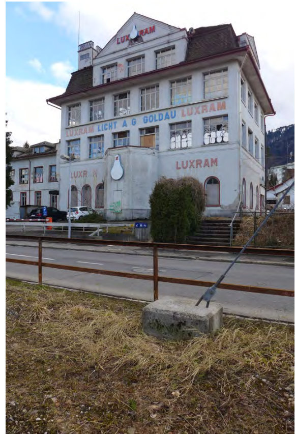
Fabrikgebäude Luxram, Nordfassade (P1310125)
