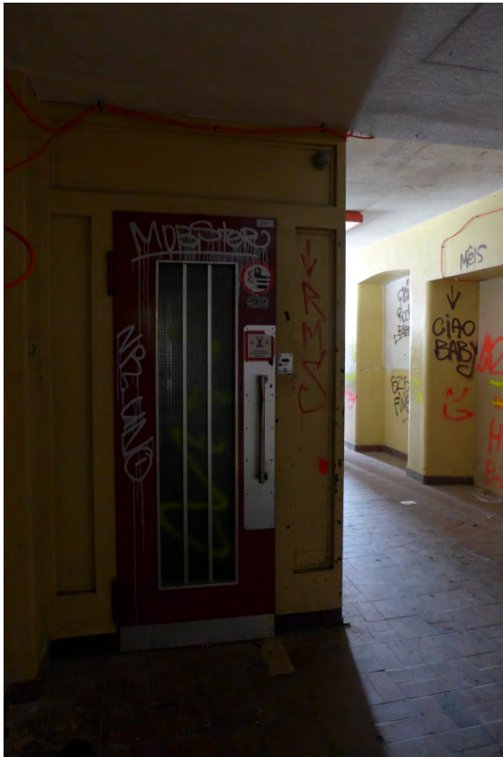
Fabrikgebäude Luxram, EG Lift (P1300958)
