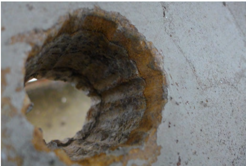
Fabrikgebäude Luxram, 2. OG Bohrung durch Boden (P1310258)
