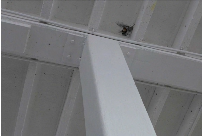
Fabrikgebäude Luxram, 2. OG Stütze Kopfplatte (P1310259)
