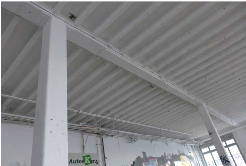
Fabrikgebäude Luxram, 2. OG Verstärkung Unterzug (P1310262)
