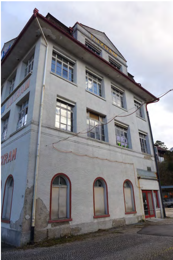
Fabrikgebäude Luxram, Westfassade (P1310137)
