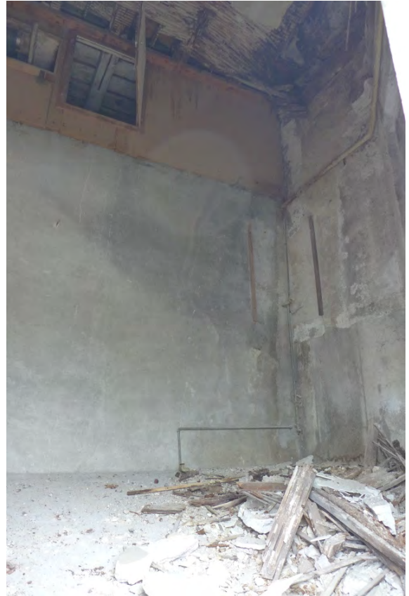
Fabrikgebäude Luxram, Erkervorbau (P1300970)
