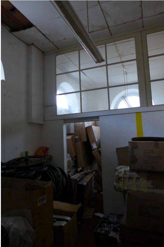
Fabrikgebäude Luxram, EG Lagerraum (P1310195)
