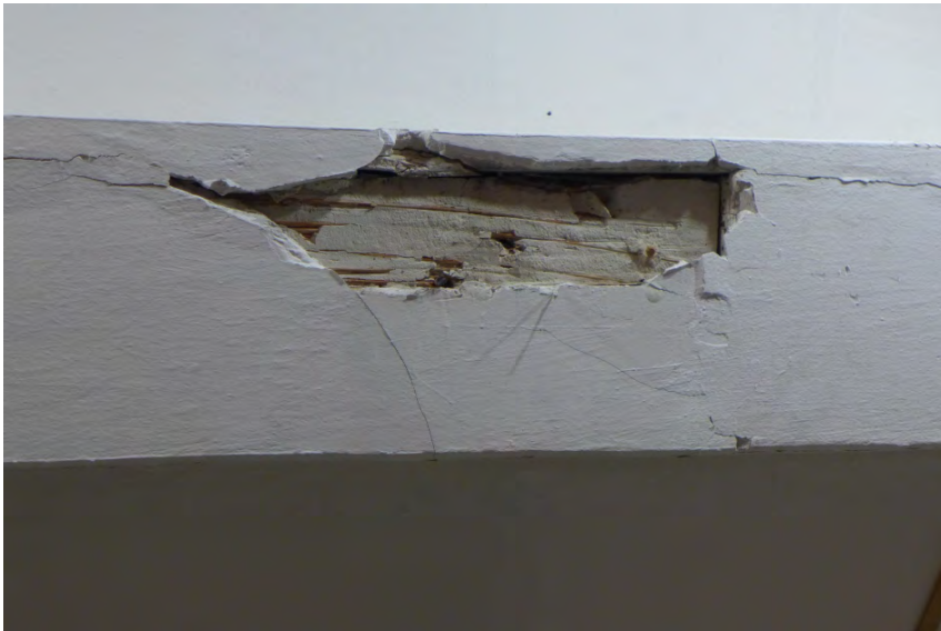
Fabrikgebäude Luxram, 1. DG Verkleidung Holzunterzüge (P1310235)
