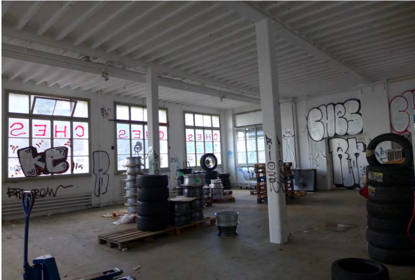
Fabrikgebäude Luxram, 2. OG ehem. Produktionsraum (P1310238)
