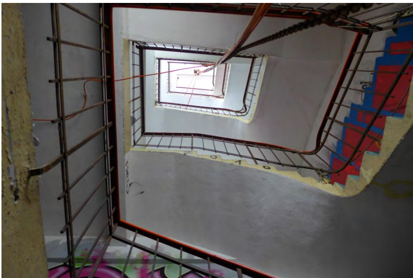
Fabrikgebäude Luxram, EG Treppenaug (P1300902)
