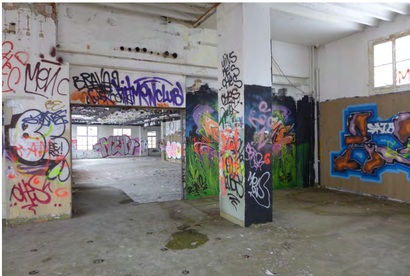
Fabrikgebäude Luxram, 1. OG Durchgang zu Gebäude Güterstr. 5 (P1300918)
