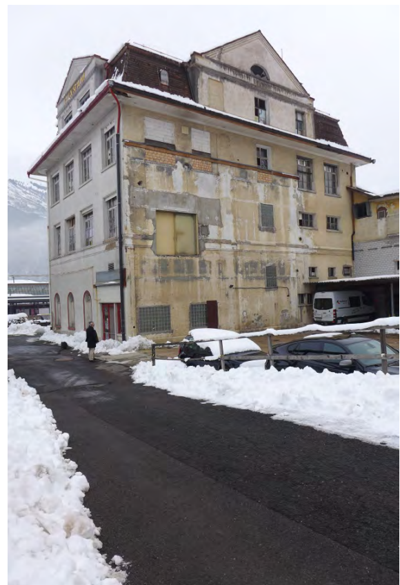
Fabrikgebäude Luxram, Südfassade (P1300961)
