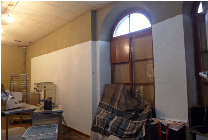
Fabrikgebäude Luxram, EG Lagerraum (P1310185)
