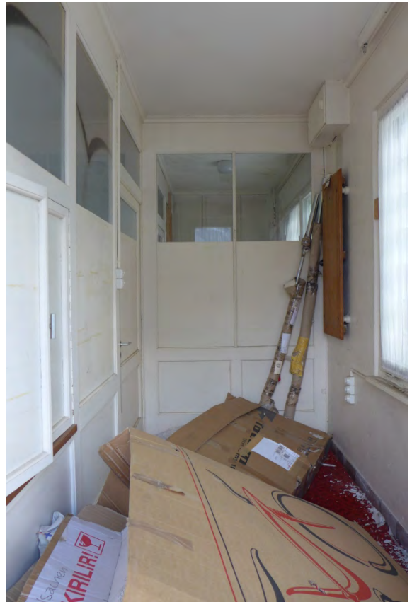
Fabrikgebäude Luxram, EG Raum bei Korridor (P1310150)
