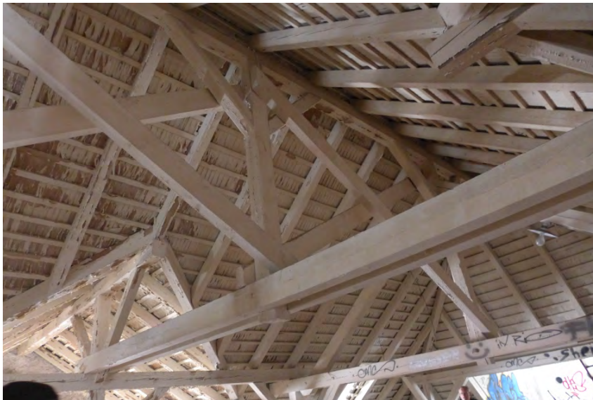
Fabrikgebäude Luxram, 2. DG Hängewerk (P1300939)
