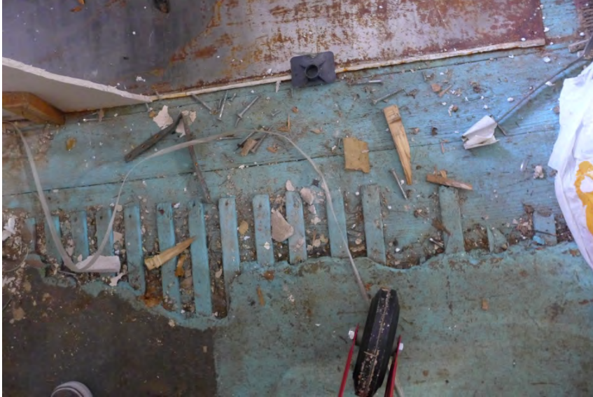
Fabrikgebäude Luxram, 1. DG Holzzement auf Riemenboden (P1310224)
