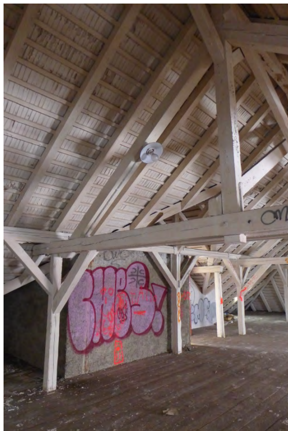
Fabrikgebäude Luxram, 2. DG Dachstuhl (P1300947)
