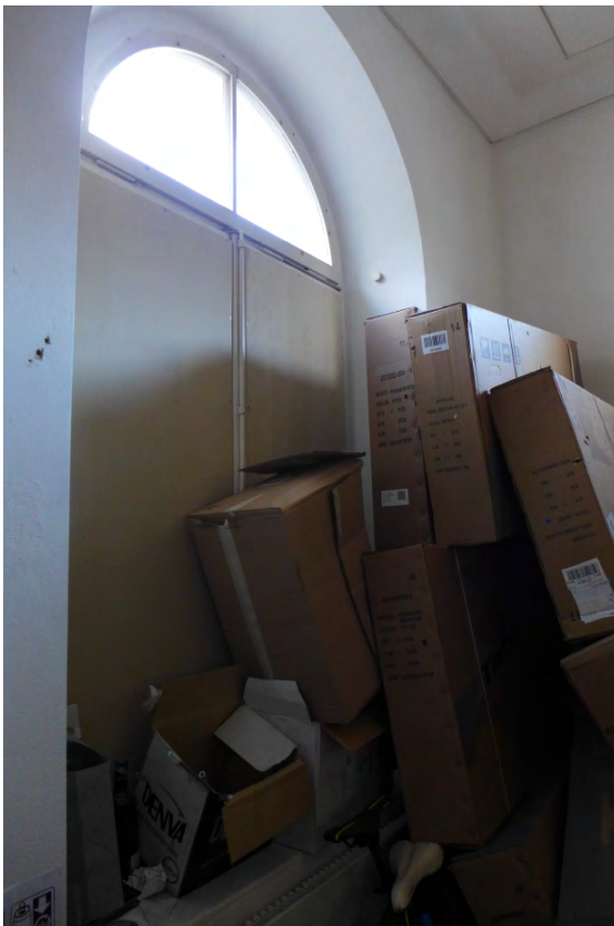
Fabrikgebäude Luxram, EG Lagerraum (P1310197)
