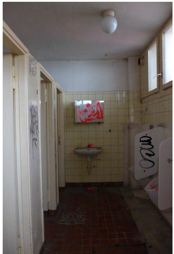
Fabrikgebäude Luxram, EG Toiletten (P1300906)
