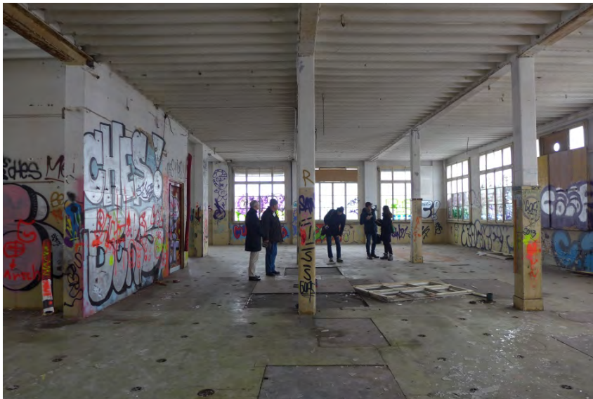
Fabrikgebäude Luxram, 1. OG ehem. Produktionsraum (P1300920)
