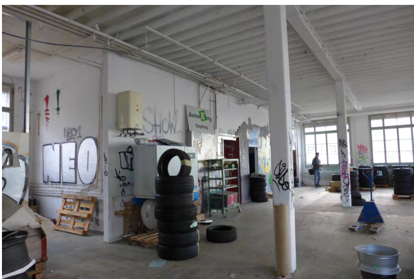
Fabrikgebäude Luxram, 2. OG ehem. Produktionsraum (P1310246)
