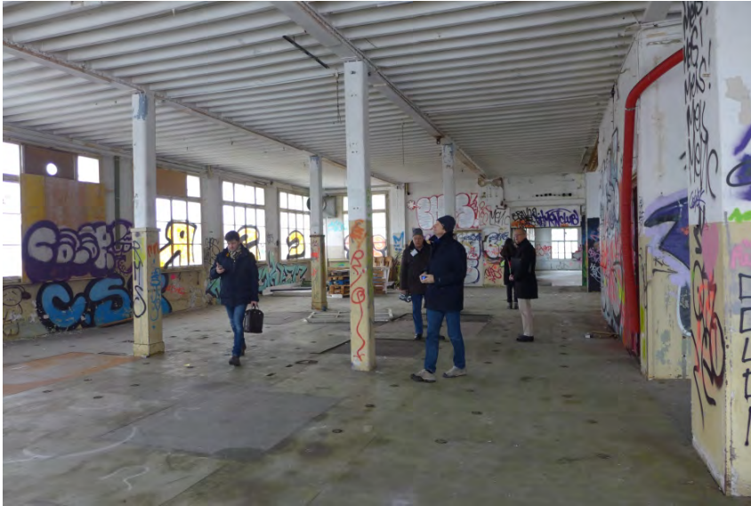
Fabrikgebäude Luxram, 1. OG ehem. Produktionsraum (P1300915)
