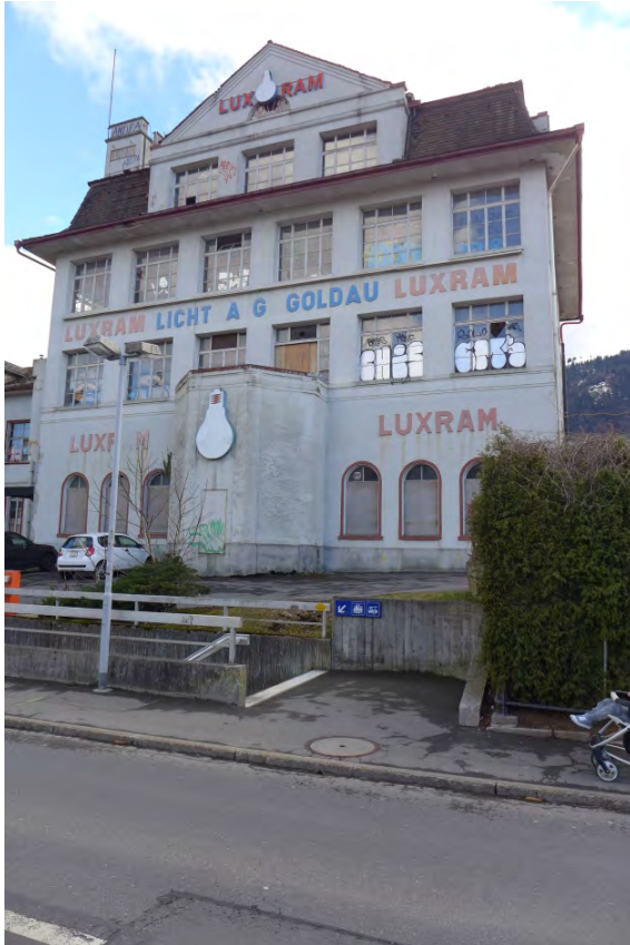
Fabrikgebäude Luxram, Nordfassade (P1310123)
