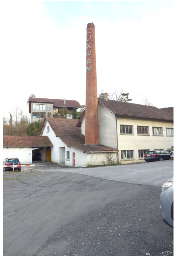
Kesselhaus mit Hochkamin (P1310163)
