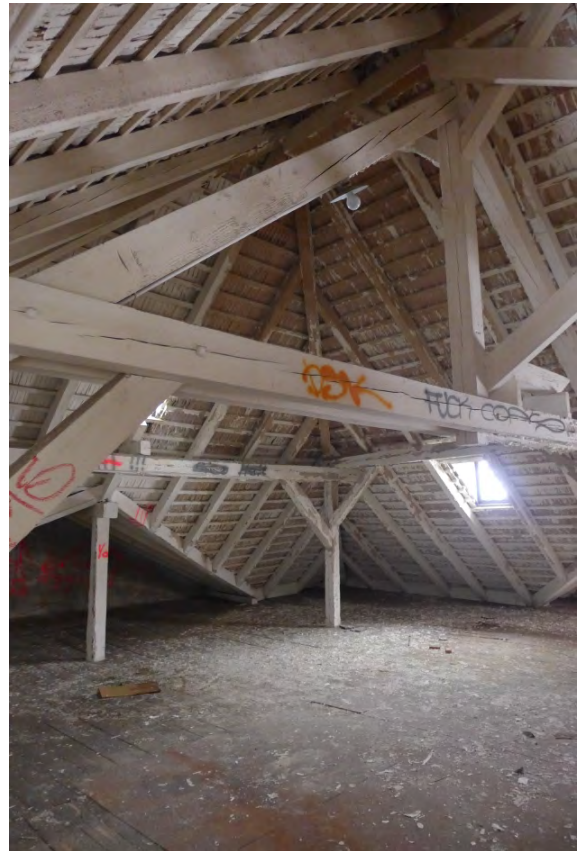
Fabrikgebäude Luxram, 2. DG Dachstuhl (P1300938)
