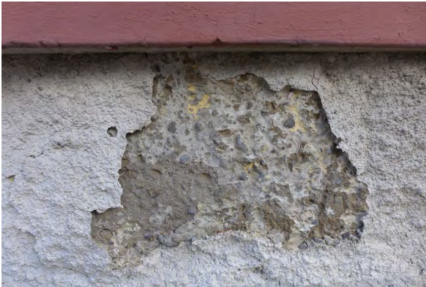
Fabrikgebäude Luxram, Putzschichten (P1310141)
