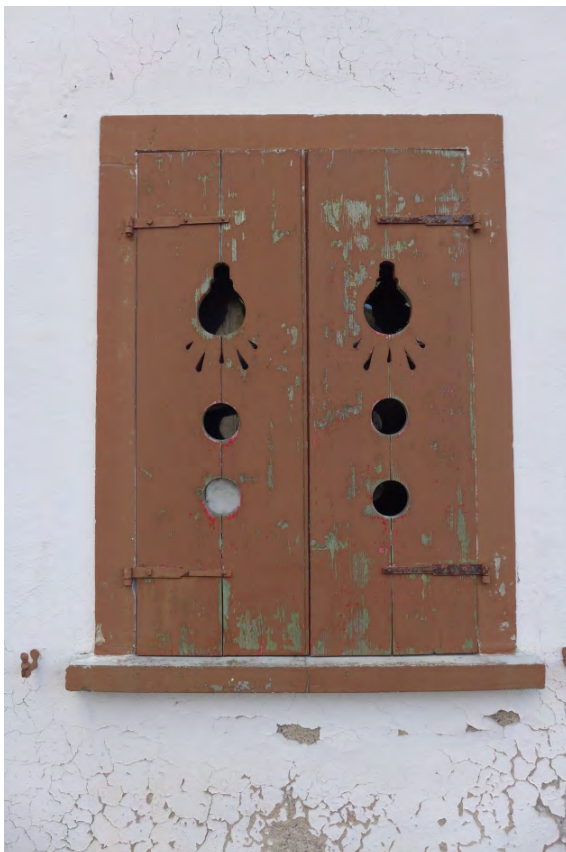
Vorbau zu Kesselhaus, Fensterläden mit Glühlampenausschnitt (P1310153)
