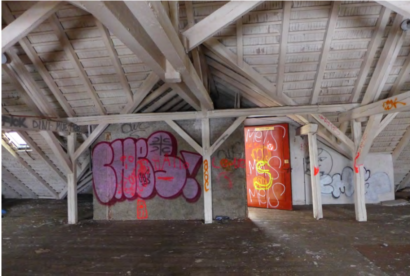
Fabrikgebäude Luxram, 2. DG Dachstuhl bei Treppenhaus (P1300942)
