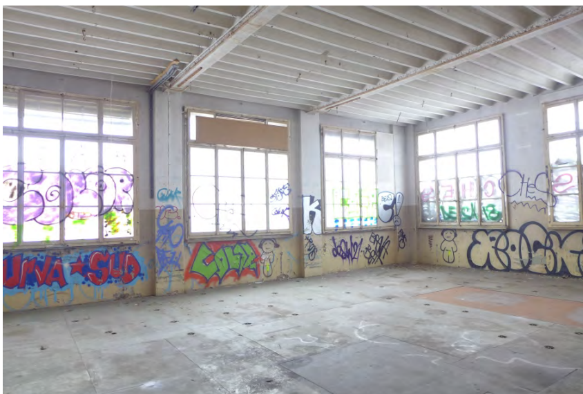
Fabrikgebäude Luxram, 1. OG ehem. Produktionsraum (P1300914)
