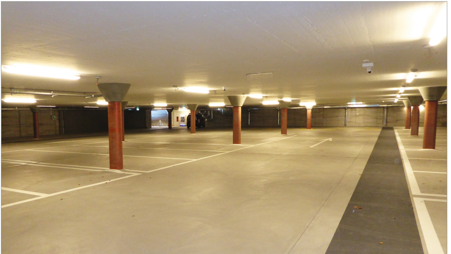
Tiefgarage Bahnhof Arth-Goldau
