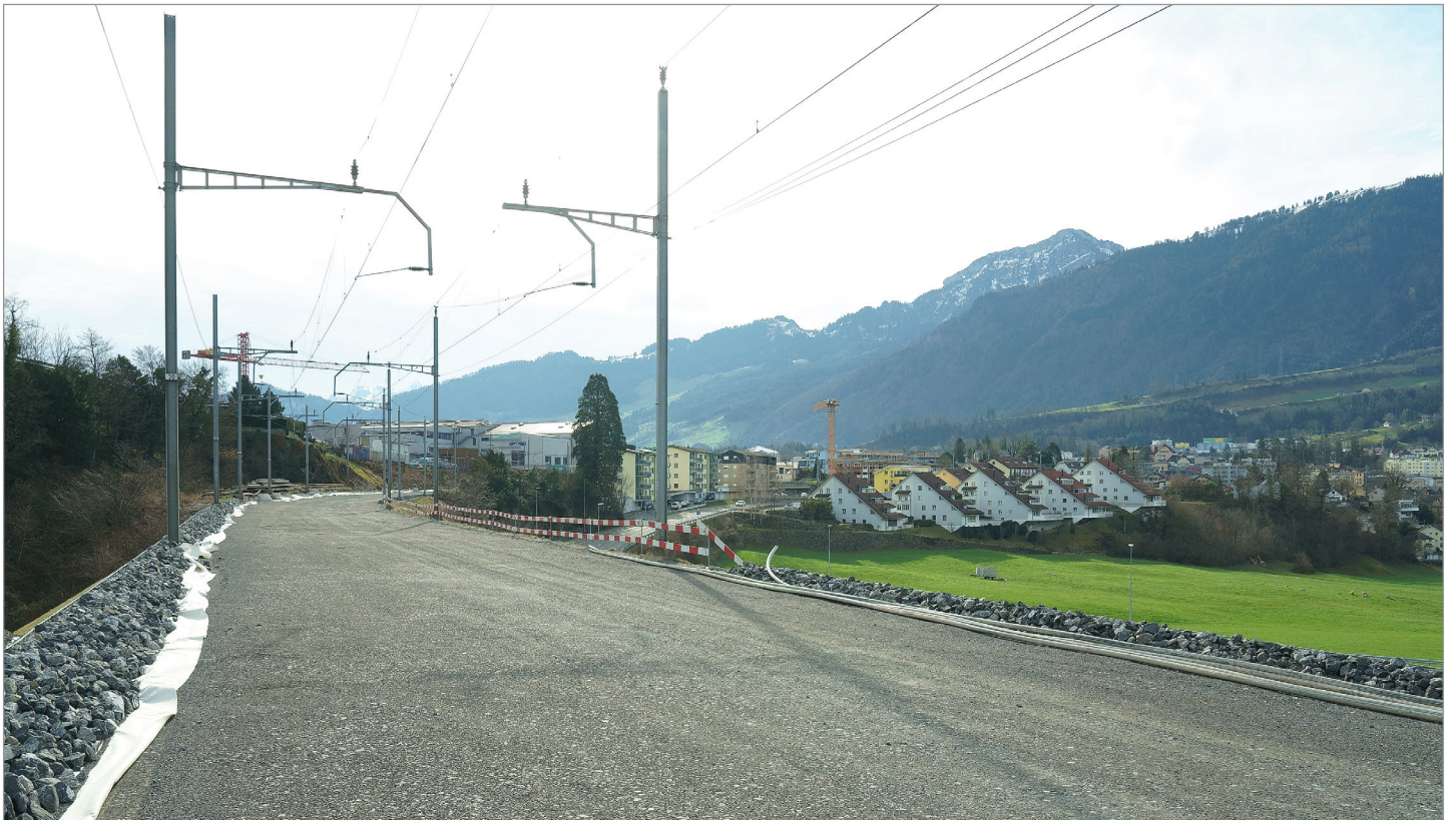
Trasse für Neubau der SBB Geleise Linie Arth-Goldau – Zug
